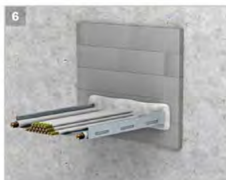
6 Controllare la sigillatura e applicare l'etichetta
