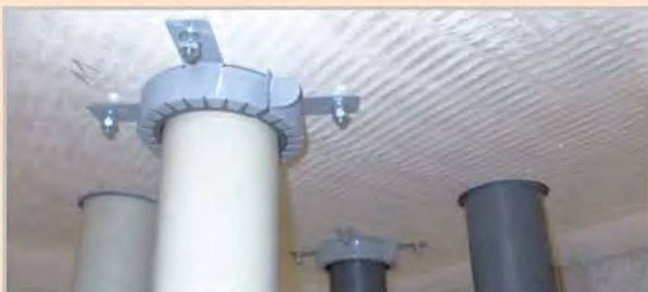
L'immagine mostra una sigillatura di tubi combustibili montati a solaio con il collare antincendio AWM II del Sistema ROKU® MFS Sigillatura di attraversamenti combinati.
