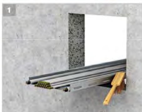
1 Pulire l'apertura e rimuovere tutti i detriti.
