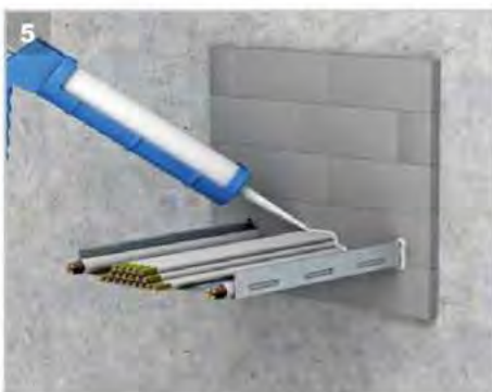
5 Dopo l'inserimento dei mattoni, chiudere tutti i giunti con il sigillante ROKU® FL.
